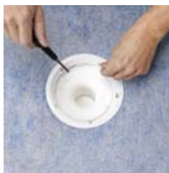
Passa in avsedda skruvar till skruvhålen i brunnen.
