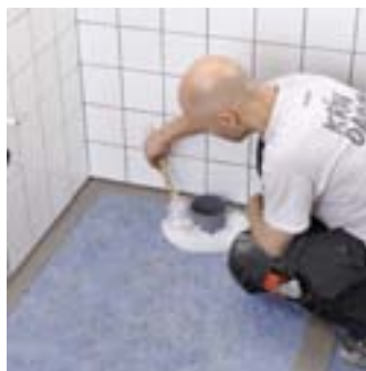
5. Pensla SCHÖNOX HA runt rör och trä på rörmanschett.
