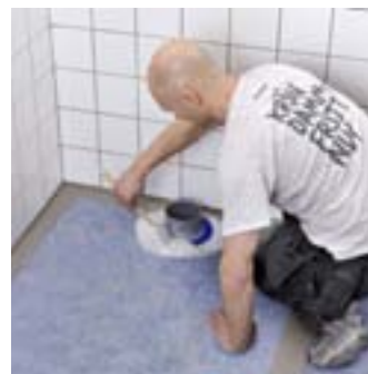
7. Förslut manschetten genom att applicera SCHÖNOX HA över ytterkanten samt ca 1 cm ut på röret.
