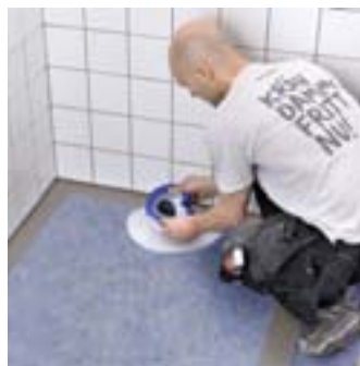
6. Rörmanschetten ska sitta en bit upp/ut på röret för att säkerställa vattentätheten.
