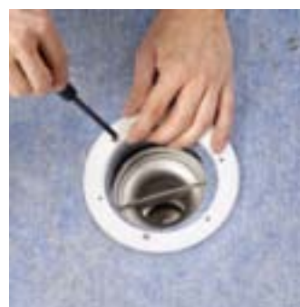
Skruva fast klämringen enligt Blüchers monteringsanvisning.
