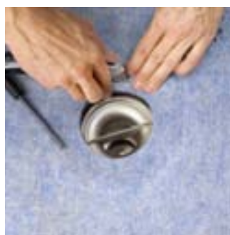
Klipp eller skär ut för tapphål. Tryck tapparna igenom SCHÖNOX WSF/brunnsmanschett.
