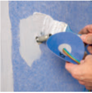
Pensla AquaStop runt röret och ca 1 cm på röret.
