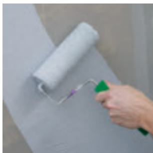
Applicering av 2:a lagret AquaStop.
