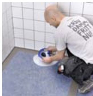
6. Rörmanschetten ska sitta en bit upp/ut på röret för att säkerställa vattentätheten.
