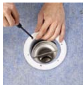
Skruva fast klämringen enligt Blüchers monteringsanvisning.
