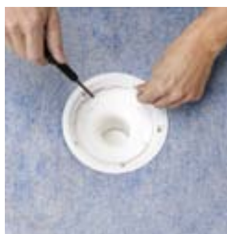
Passa in avsedda skruvar till skruvhålen i brunnen.
