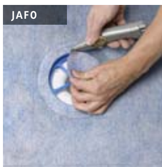
Skär ut hålet i SCHÖNOX WSF/brunnsmanschett, följ skärmallens insida.
