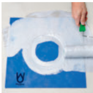
Applicera AquaStop på golvet och på brunsmanschetten.
