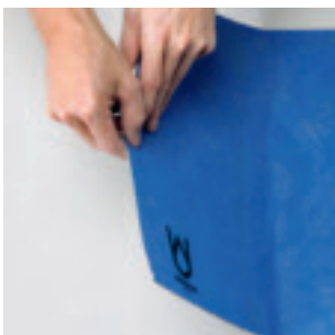
Avlägsna skyddspappret på Brunsmanschetten och montera över brunnhålet. Var noggrann så det inte bildas luftfickor eller blåsor.
