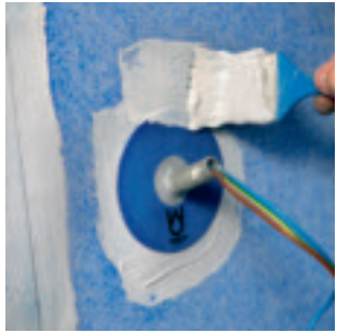
Trä anpassad rörmanschett över röret och pensla ett täckande lager AquaStop på och runt manschetten.
